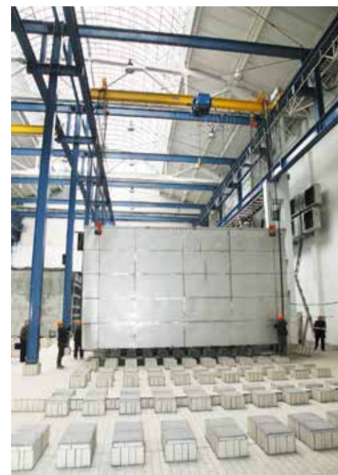
2011 год. Идет установка ванн, 8-метровых по длине, 4,5-метровых по глубине. Ширина ванн, разных по назначению, составляет от 1,7 до 2,3 метра
